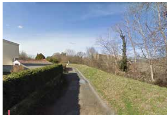
La digue de l'Estey avant les travaux
