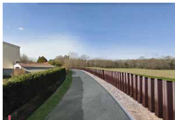
La future digue de l'Estey
